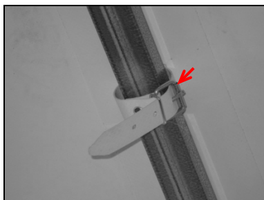
Correa tensora en el travesaño
