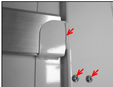
Cajetín de remonta en el pilar de esquina
