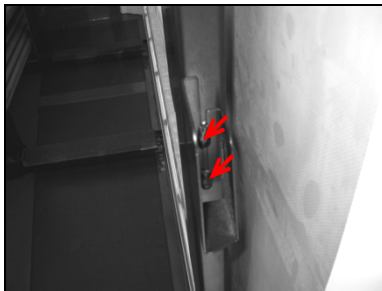
Cajetín de remonta en el pilar del centro
